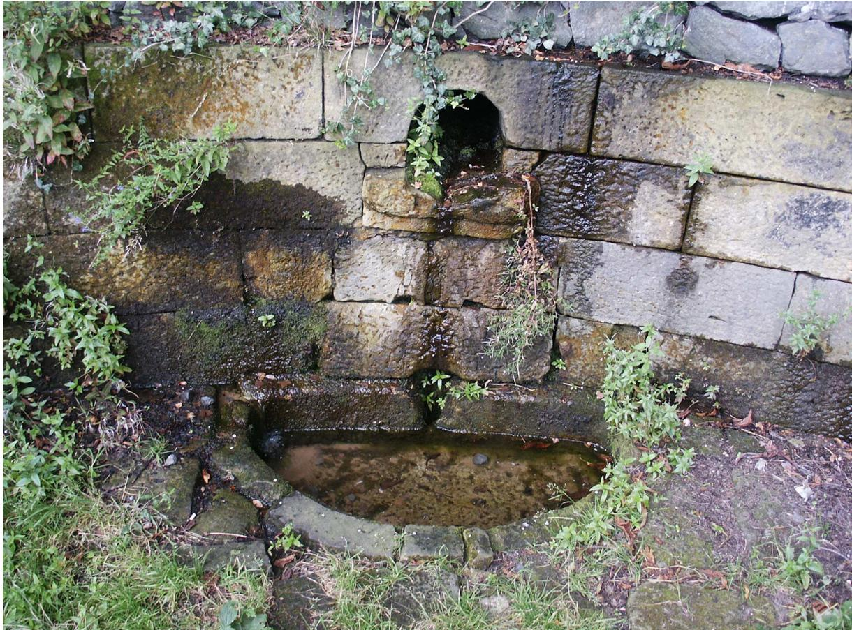
**Abb. 2: Quellfassung an der Grundstücksmauer 2005**
